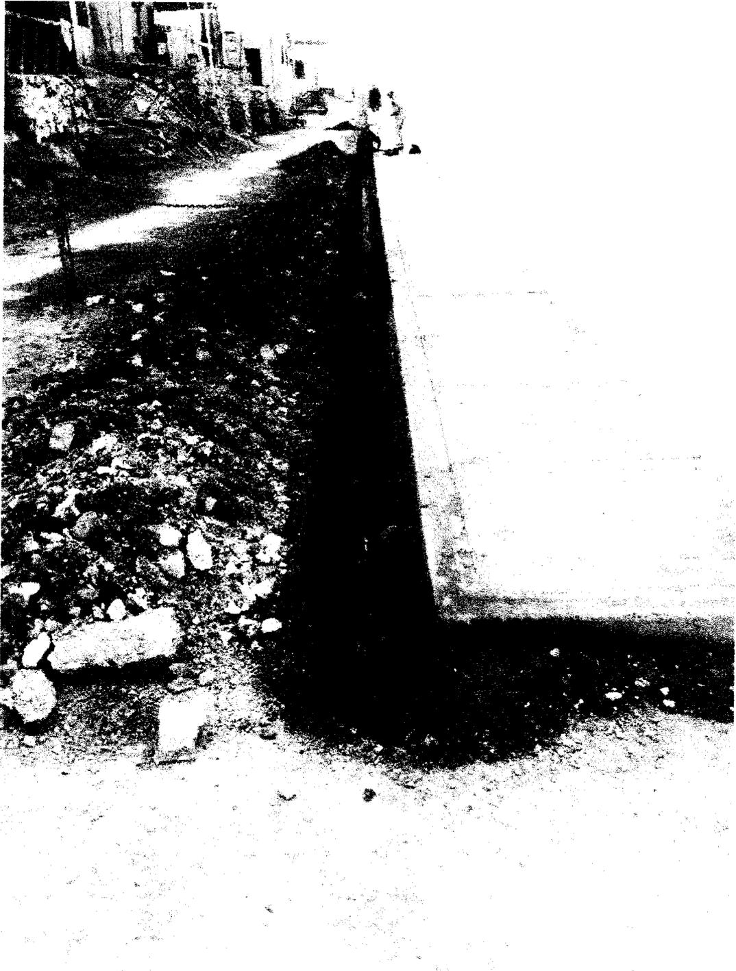
Fotografía N°01: Vista de zanja excavada para instalación de tubería HDPE – Adicional de Obra N°01.
